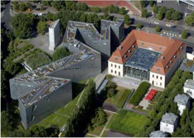
Jüdisches Museum Berlin, Luftaufnahme des Altbaus und Libeskind-Baus
